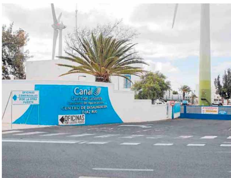
Instalaciones junto a Las Caletas de Canal Gestión Lanzarote, heredadas de Inalsa. COBER LANZAROTE
